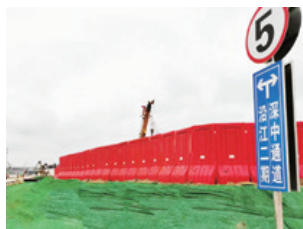
▶ 裸露土及易起尘 物料100%覆盖
