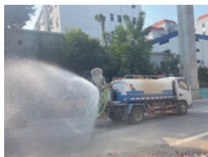
▶ 易起尘作业面 100%湿法施工
