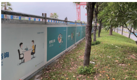
施工沿线设置隔声围挡
