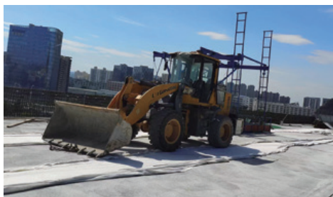
采用减震板、橡胶轮胎机械设备等降噪措施
