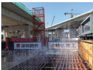
▶ 出入口 100%安装冲洗设施
