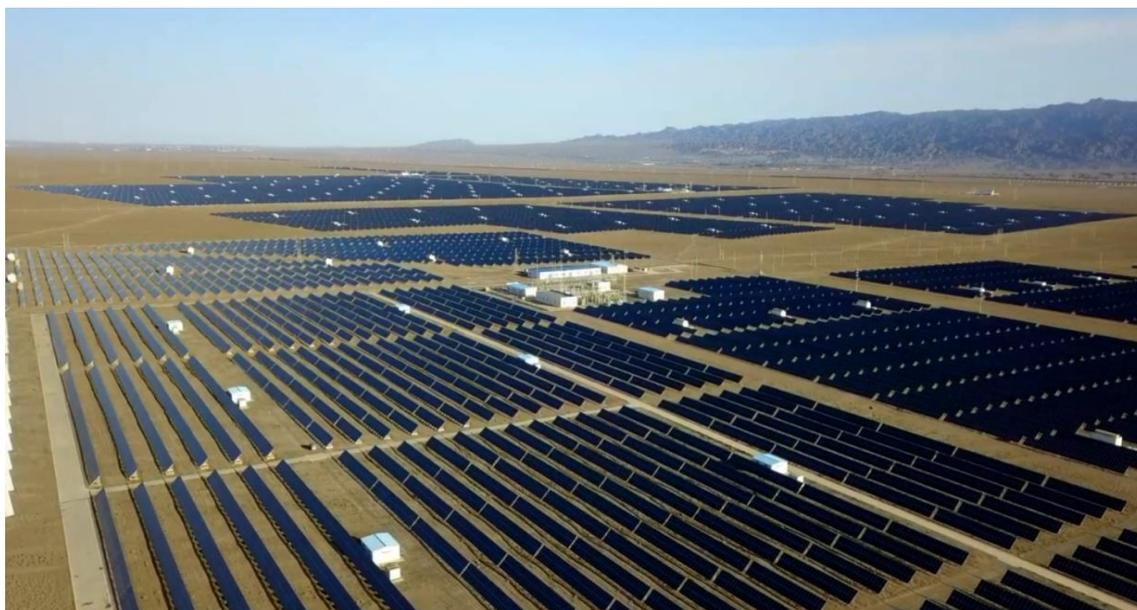
甘肃嘉峪关光伏项目位于甘肃省嘉峪关城区以西、讨赖河北岸，项目总装机容量10.7万千瓦，是嘉峪关市首个也是河西地区单场装机规模最大的太阳能光伏电站。项目投产以来在地方经济建设和节能减排等方面做出了突出贡献，连续被中电联评为年度光伏电站生产运行指标对标AAAAA级电站。
