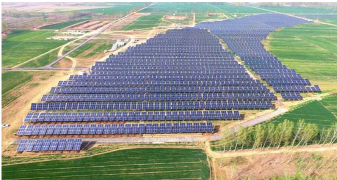
山东汶上农光互补项目位于山东省汶上县阳城煤矿采煤沉陷区，装机容量 10 万千瓦，采用平单轴跟踪支架和固定支架两种形式，是山东省采煤沉陷区综合治理利用项目和新旧动能转换优选典型项目。
