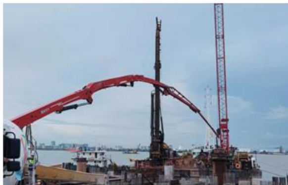
图 7：LNG 应急调峰气源站配套码头工程主码头桩基浇筑
