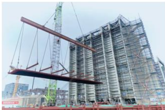
图 6：珠江 LNG 电厂二期项目正吊装余热锅炉模块
