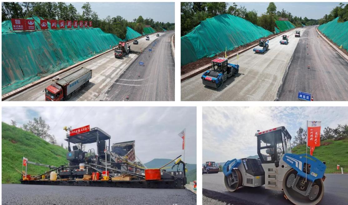
同时，智能摊铺机通过厘米级精准定位控制技术，实现精准的贴边摊铺压实作业，路缘及边角位置无需二次夯实，保证压实路面压实质量的一次成型；通过高精度定位和红外线温传感器等对摊铺过程中摊铺速度、厚度、温度及位置进行监测，进而实现对智能摊铺机的实时控制保证摊铺质量。智能压路机通过压实度传感器进行数据分析，避免欠压过压等问题；通过前后共两组组合雷达避障、利用高精度定位及车辆动态模型智能防撞、在施工场景中设置电子围栏等措施保障施工安全。
