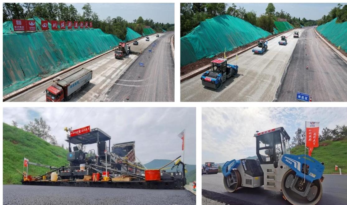
同时，智能摊铺机通过厘米级精准定位控制技术，实现精准的贴边摊铺压实作业，路缘及边角位置无需二次夯实，保证压实路面压实质量的一次成型；通过高精度定位和红外线温传感器等对摊铺过程中摊铺速度、厚度、温度及位置进行监测，进而实现对智能摊铺机的实时控制保证摊铺质量。智能压路机通过压实度传感器进行数据分析，避免欠压过压等问题；通过前后共两组组合雷达避障、利用高精准定位及车辆动态模型智能防撞、在施工场景中设置电子围栏等措施保障施工安全。
