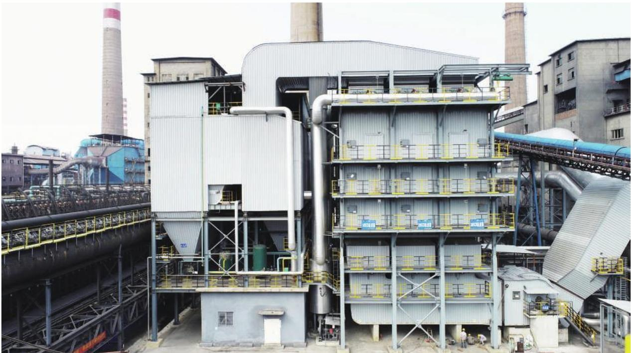
焦化厂三四焦焦炉烟气脱硫脱硝系统 4 月 9 日正式投入运行。三四焦焦炉烟气脱硫脱硝系统是继一、五焦焦炉烟气脱硫脱硝系统后，公司第三套焦炉烟气处理系统，总投资约 5000 万元。该系统是为三四焦车间 117 孔及 120 孔 JN43-80 型顶装两套焦炉系统配建的烟道气净化装置，主要由 SDS 干法脱硫工艺、布袋除尘及输灰系统、中低温 SCR 脱硝系统、余热回收系统、引风机及烟气系统组成。项目投用后，有利于焦炉实现超低排放目标，促进企业绿色环保发展。图为投运后的三四焦焦炉烟气脱硫脱硝系统。
