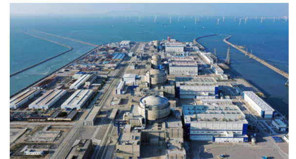
福清核电厂区全景
