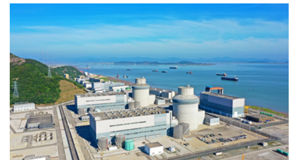
三门核电一期工程
