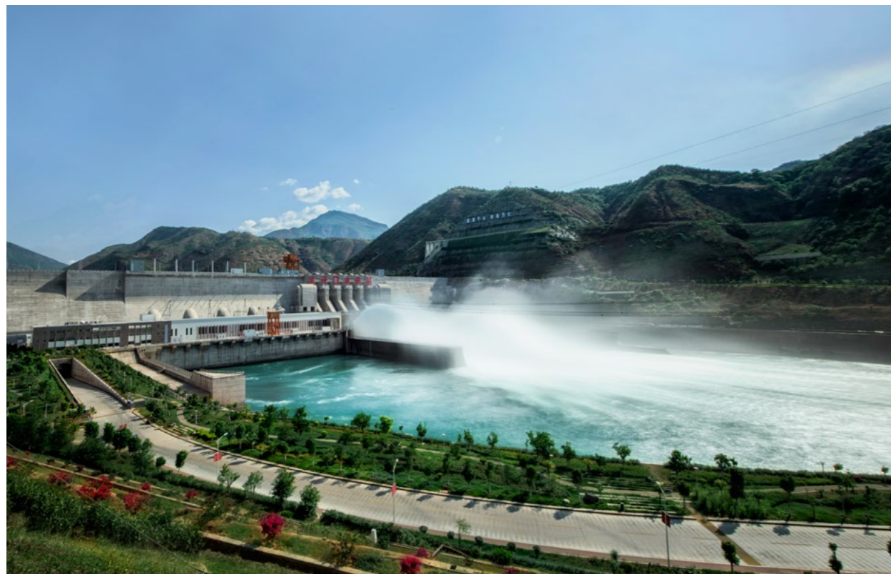
龙开口水电站工程全貌
