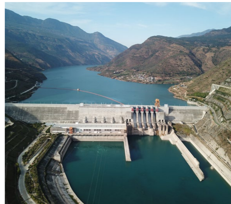
龙开口水电站工程全貌
