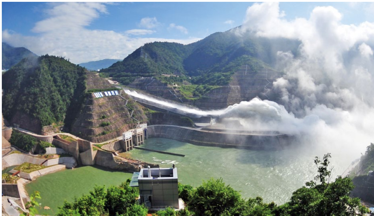
糯扎渡水电站
