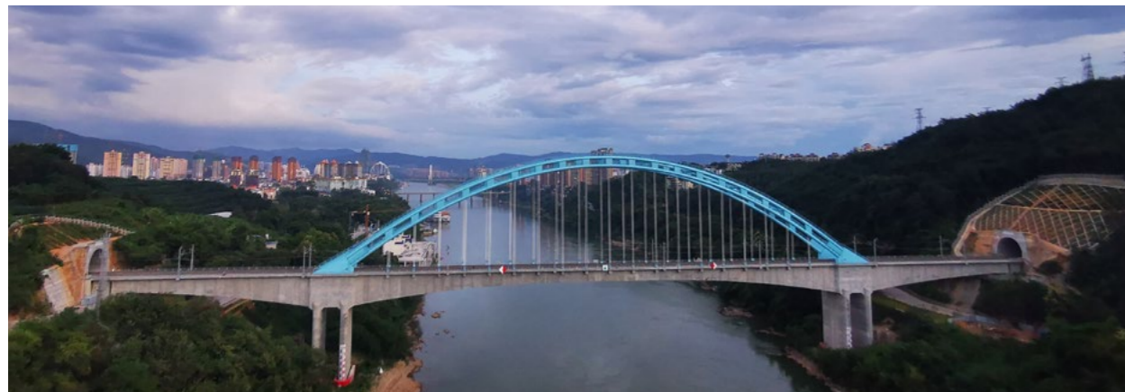
玉磨铁路景洪澜沧江双线大桥
