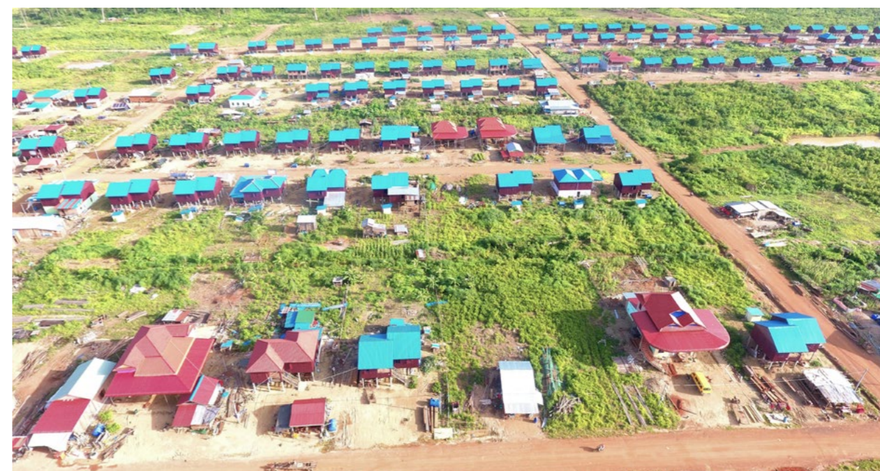
桑河二级水电站移民村
