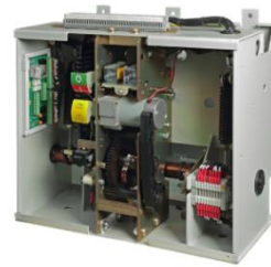
中高压断路器操作机构
