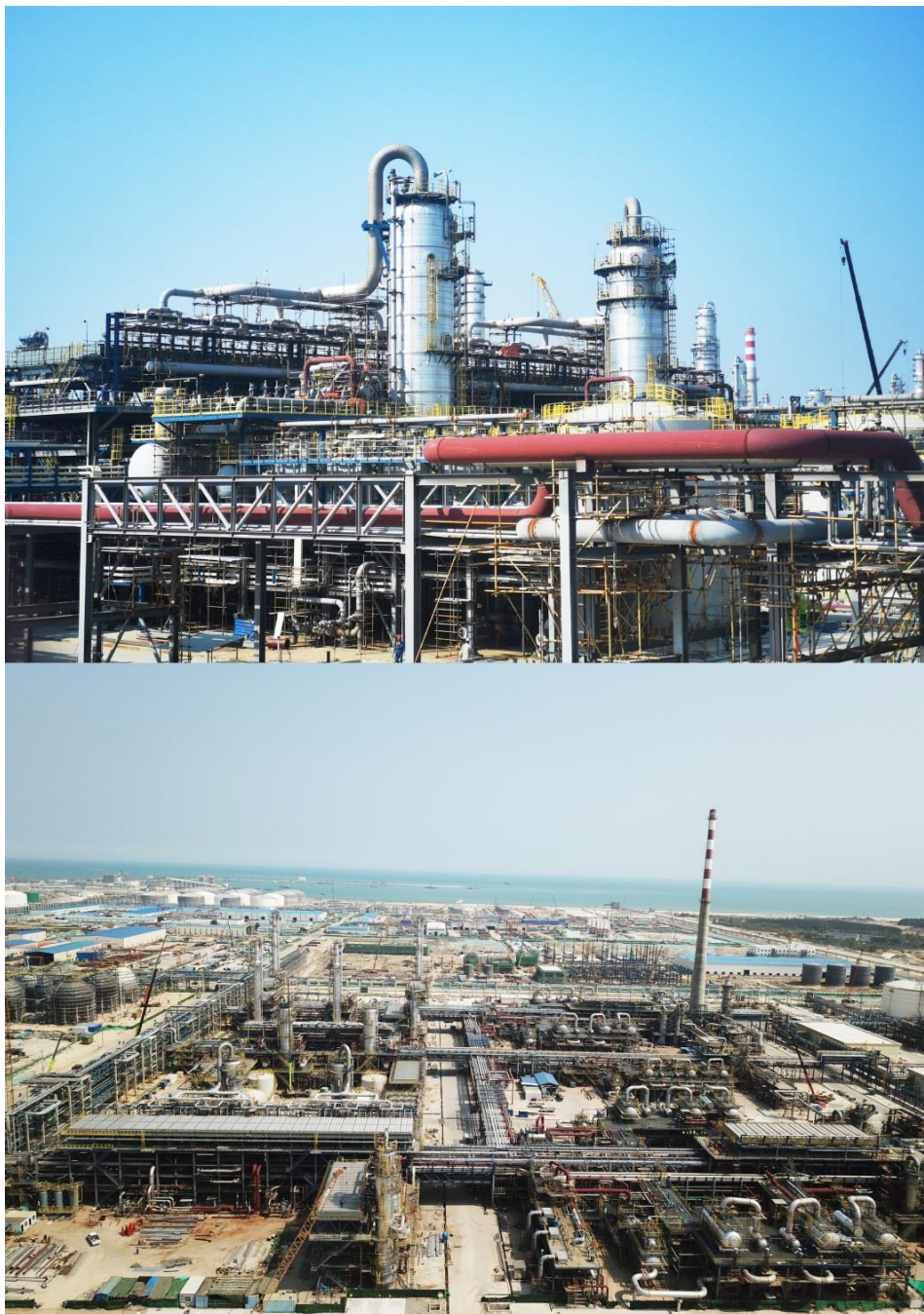
中委合资广东石化 2000 万吨/年重油加工工程主体装置项目
