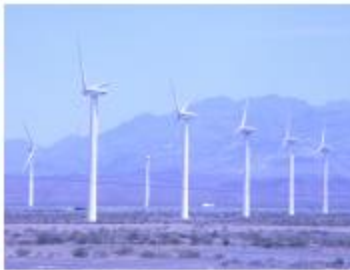
塔城发电（风力发电厂）
