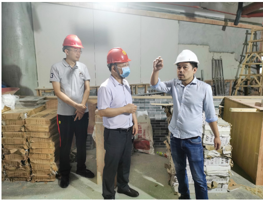
集团主要领导带队检查柳林大厦装修工地
