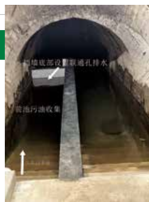
油水分离器试验 排水廊道油水分离池
