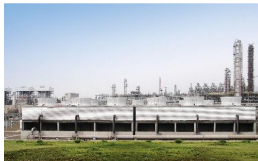
中国石油四川石化有限责任公司（四川·彭州） 39 台 NH-5000 型冷却塔
