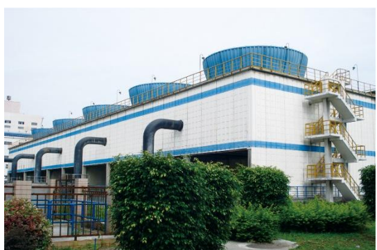
中国石油化工股份有限公司广州分公司（广东·广州） 10 台 NH-4000 型冷却塔
