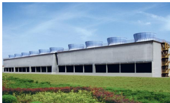
内蒙古奈伦集团股份有限公司（内蒙古·呼和浩特） 10 台 NH-4500 型冷却塔
