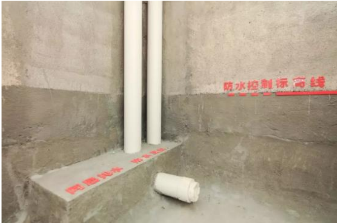
平沙九号工法样板间
