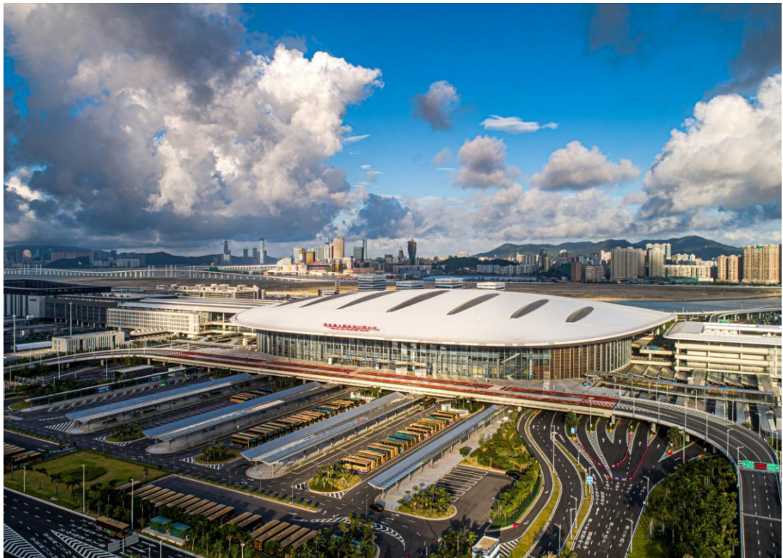
港珠澳大桥珠海公路口岸
