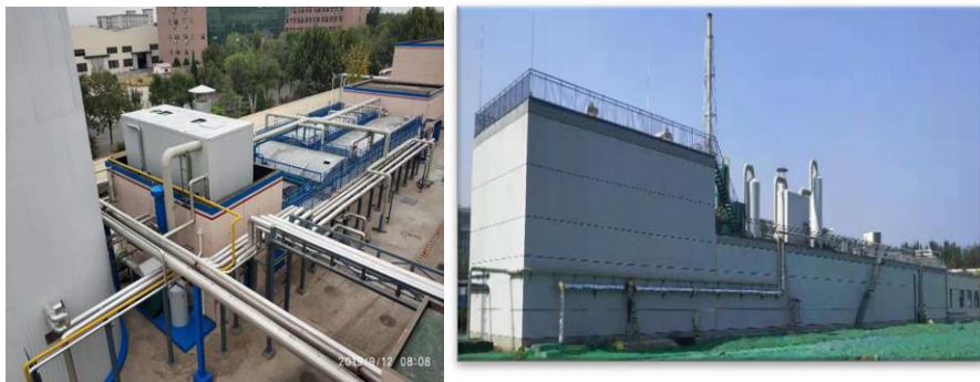
（图片分别为改扩建现代中药城厂区污水处理站和新建天士力之骄厂区污水处理站）
