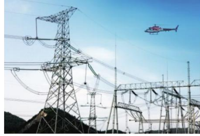
载人直升机巡检
