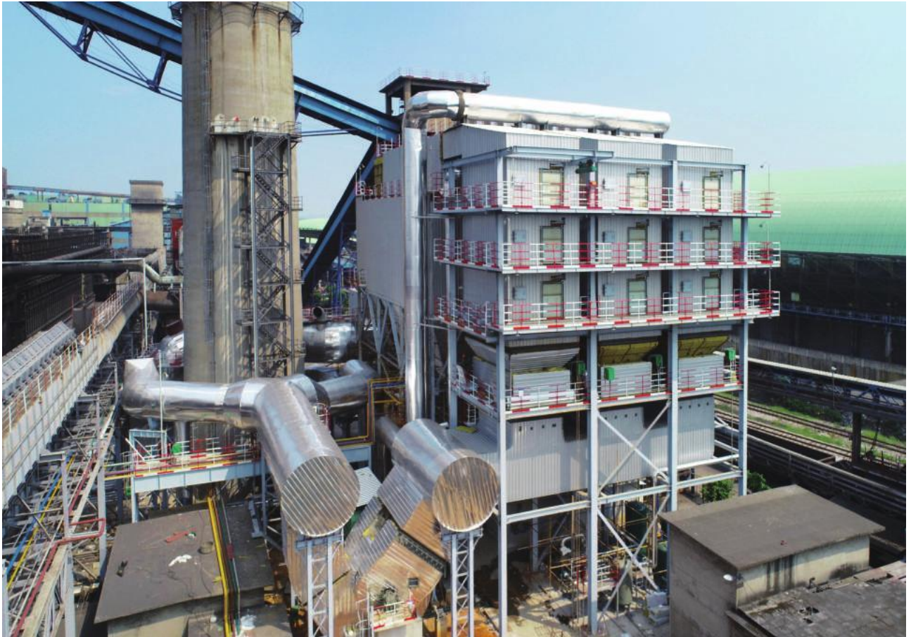
图为柳钢首套焦炉烟气脱硫脱硝技改项目，一焦车间 110 万吨产能焦炉烟气处理项目投入使用。投产后能有效地治理焦炉烟气中二氧化硫、氮氧化物等污染物的排放，提高和改善柳钢及柳州的空气质量。
