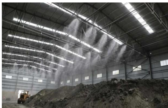
物流中心硫精矿封闭仓
