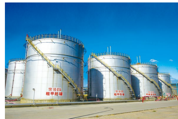
甲醇罐区 VOC 治理装置
