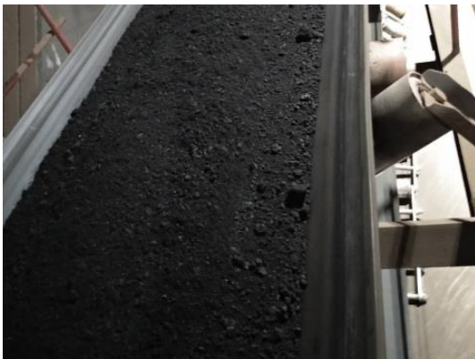
燃料化干泥皮带输送进流化床焚烧炉 (临江项目匹配的干泥连续焚烧系统)
