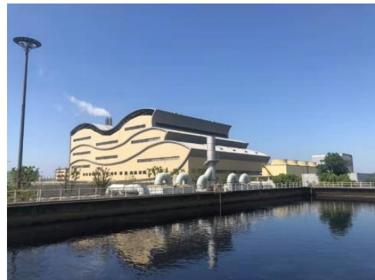
萧山 4000 吨/日污泥处理工程项目 单独焚烧
