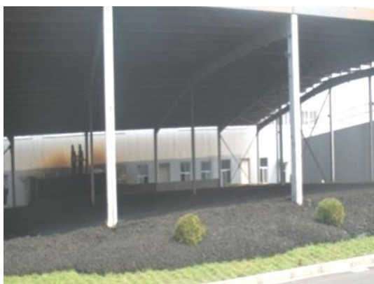
污水处理厂传统机械脱水产生的含水率 80%湿污泥
