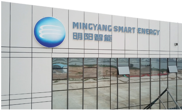
阳江基地 Yangjiang Service Base
