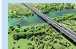
文莱波布隆跨海大桥项目
