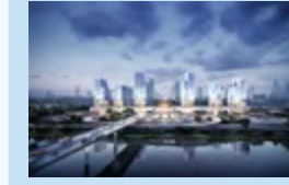
广东珠海横琴口岸及综合交通枢纽开发工程项目
