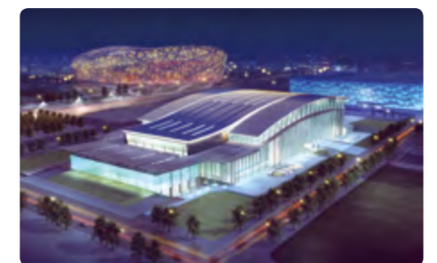
国家体育馆冬奥改造项目
