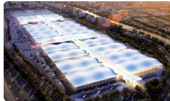
深圳国际会展中心项目
