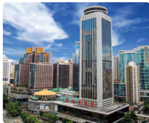
深圳国贸大厦项目
