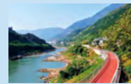
贵州赤水河谷旅游公路项目
