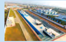
长沙市地下综合管廊项目
