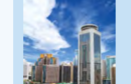
深圳国贸大厦项目
