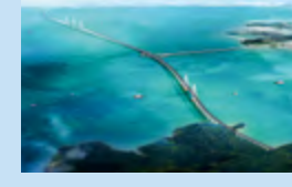
宁波舟山港主通道项目
