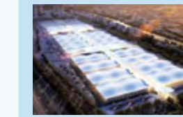
深圳国际会展中心项目
