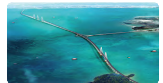
宁波舟山港主通道项目
