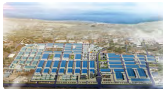
吉布提国际自贸区一期起步区工程建设项目
