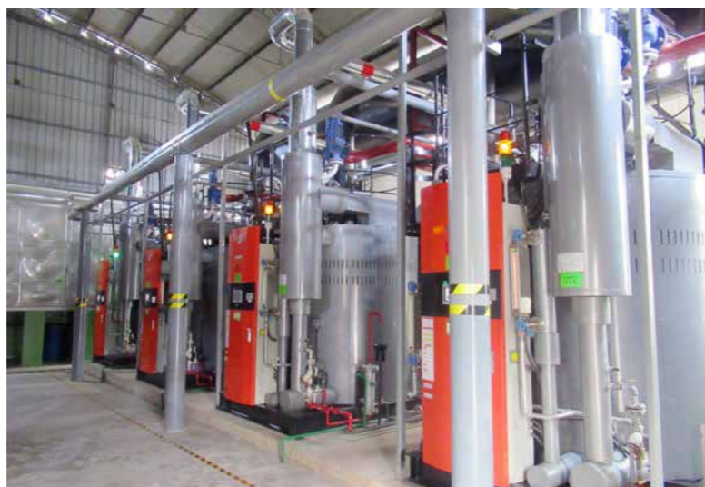
天然气锅炉改造
