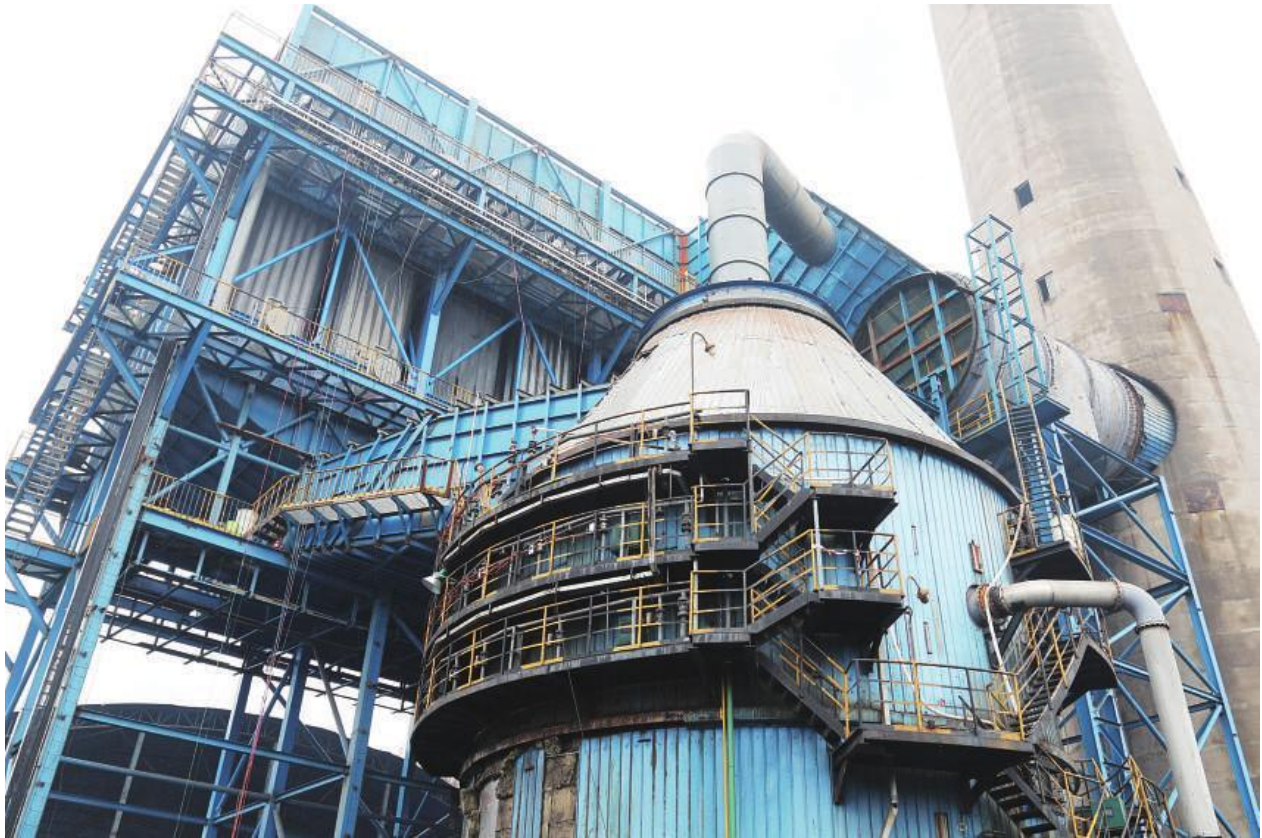
2018年5月3日，公司2号360 m 3 烧结脱硫尾气深度净化项目的核心设备——湿式电除尘器成功通电升压运行，这标志着公司烧结、球团尾气深度净化改造取得了阶段性成果。图为新建成的公司2号360 m 3 烧结脱硫尾气深度净化项目的核心设备——湿式电除尘器。
