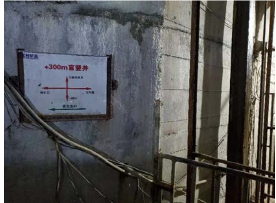
照片 4、盲竖井提升
