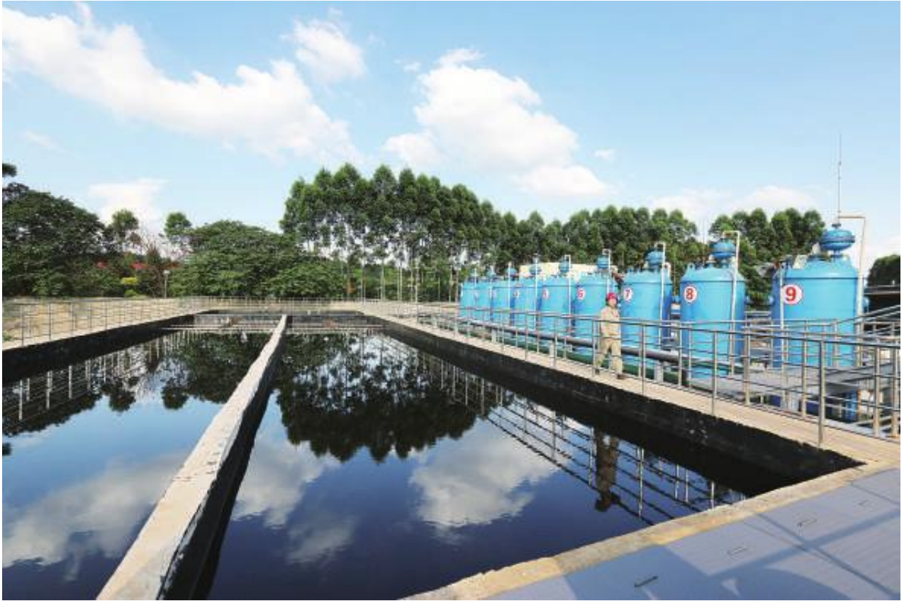
柳钢将树脂吸附工艺运用于焦化废水处理这在国内尚属首次。
