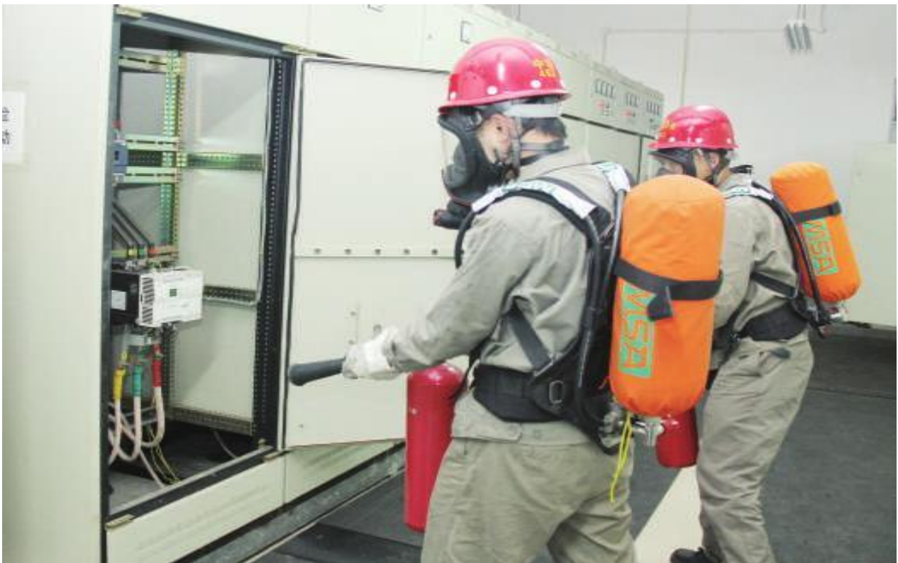
中板厂在热处理生产线 1 号、3 号配电室开展突发火灾、爆炸事故应急演练。图为演练人员对配电柜灭火
