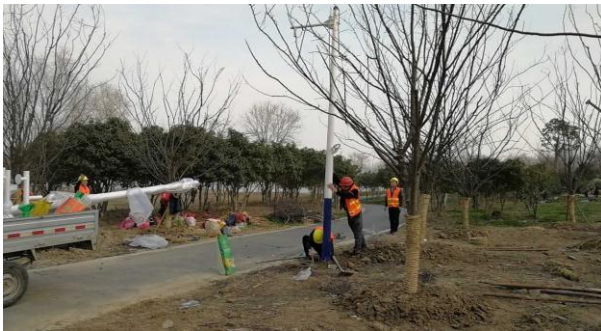
天网工程施工现场
