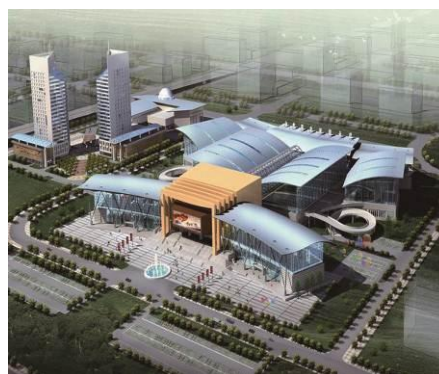
包头国际会议中心金属屋面系统
