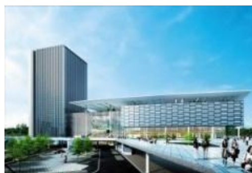
无锡火车站幕墙系统
