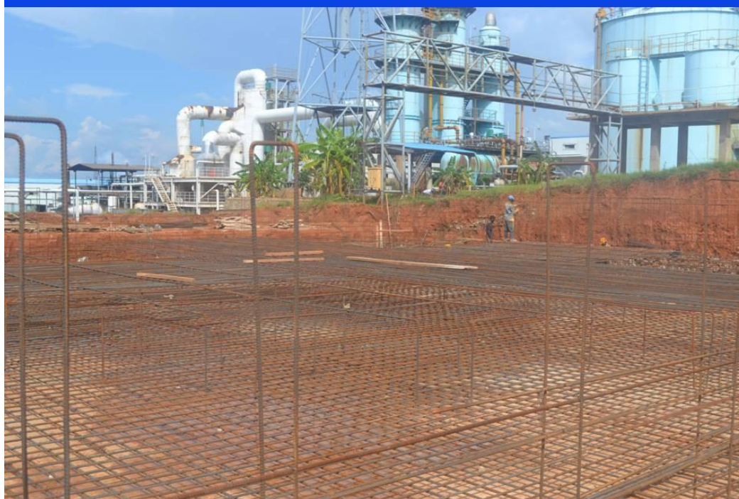
新建硫酸二期工程工地
