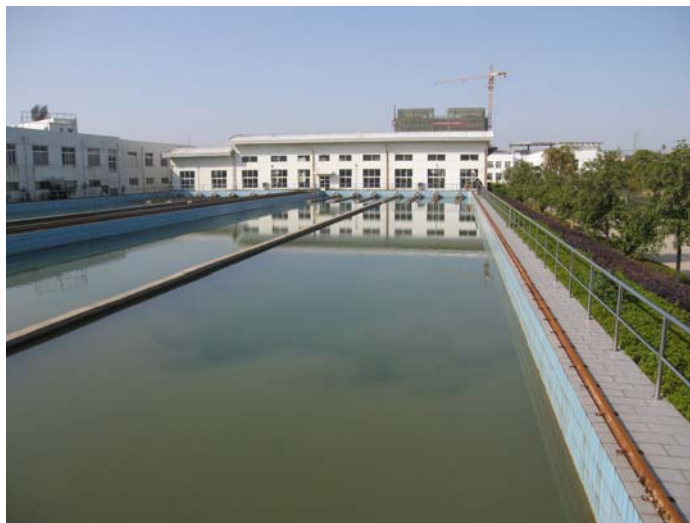
图 8-1 现状一期反应沉淀池
