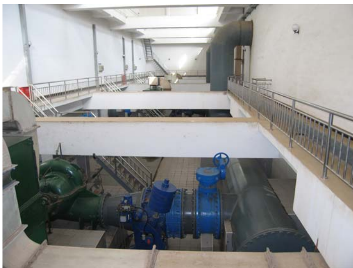
图 8-5 现状送水泵房地下部分
