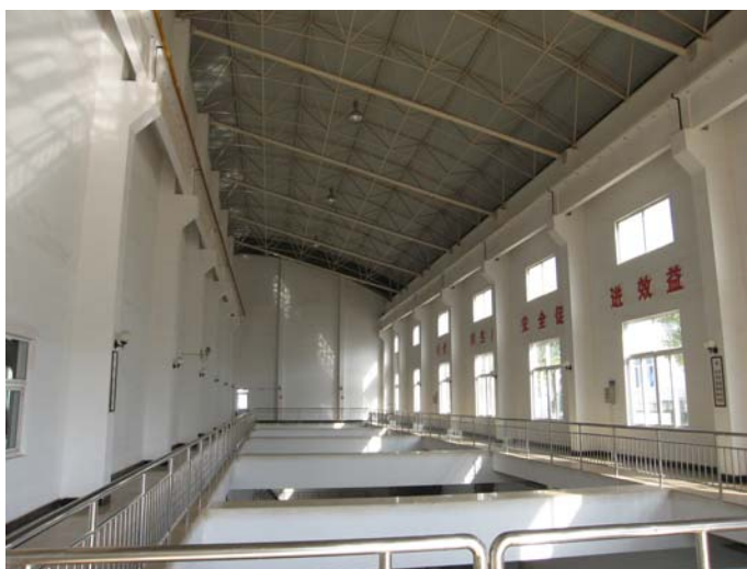
图 8-4 现状送水泵房地上部分
