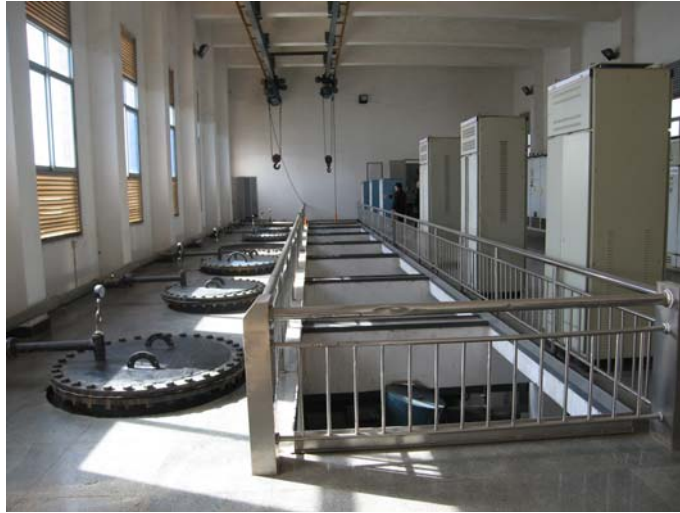
图 6-1 现状取水泵房
