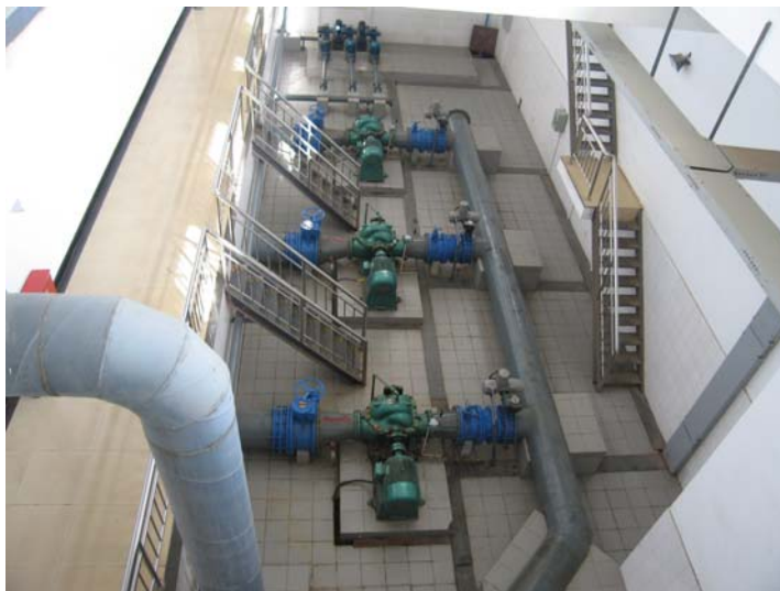
图 8-3 现状滤池反冲洗泵房
