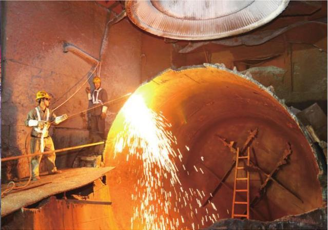
图 16. 切割拆除施 40t 转炉炉体
