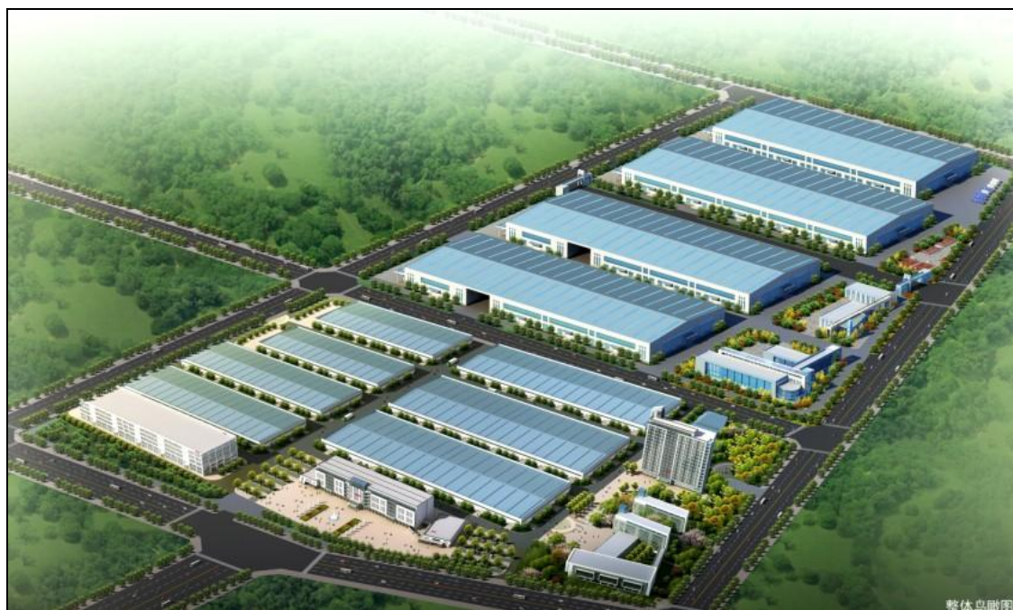
图为：公司南岗机电产业园
