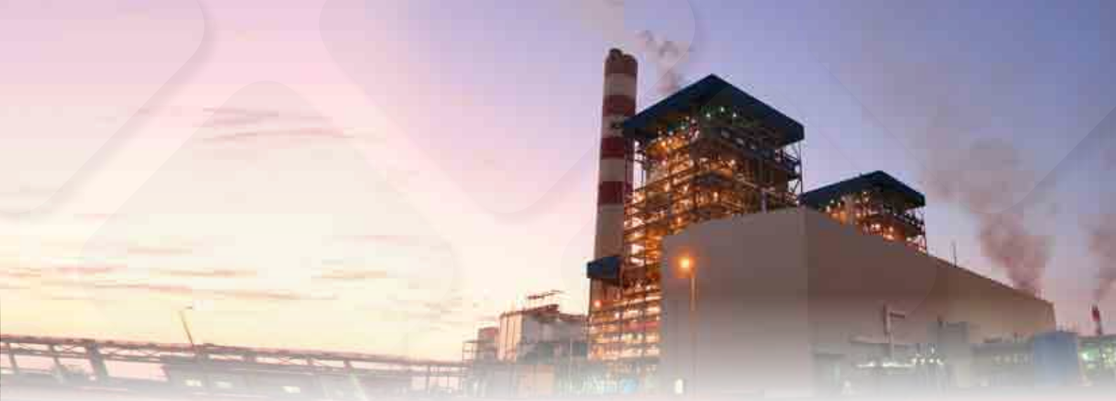
东方电气沙特拉比格2×660MW燃油电站工程
