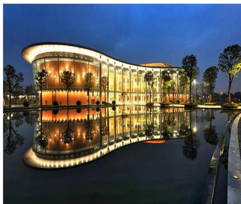
常州大剧院（鲁班奖工程）
