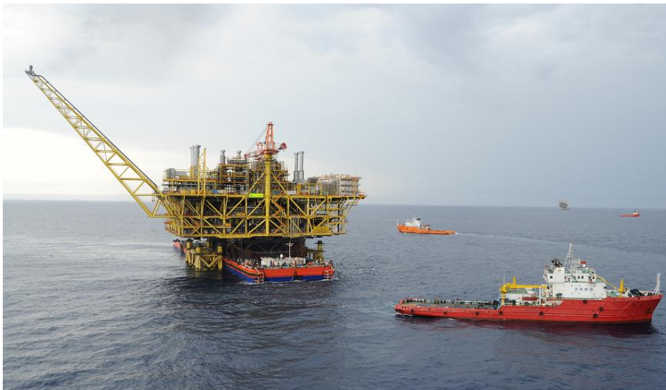
3 万吨级组块安装现场
