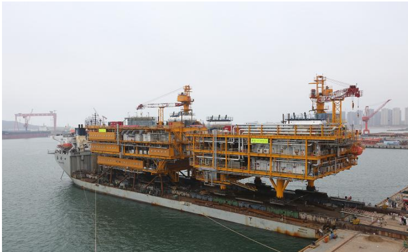
绥中 36-1 项目组块建造完成后装船
