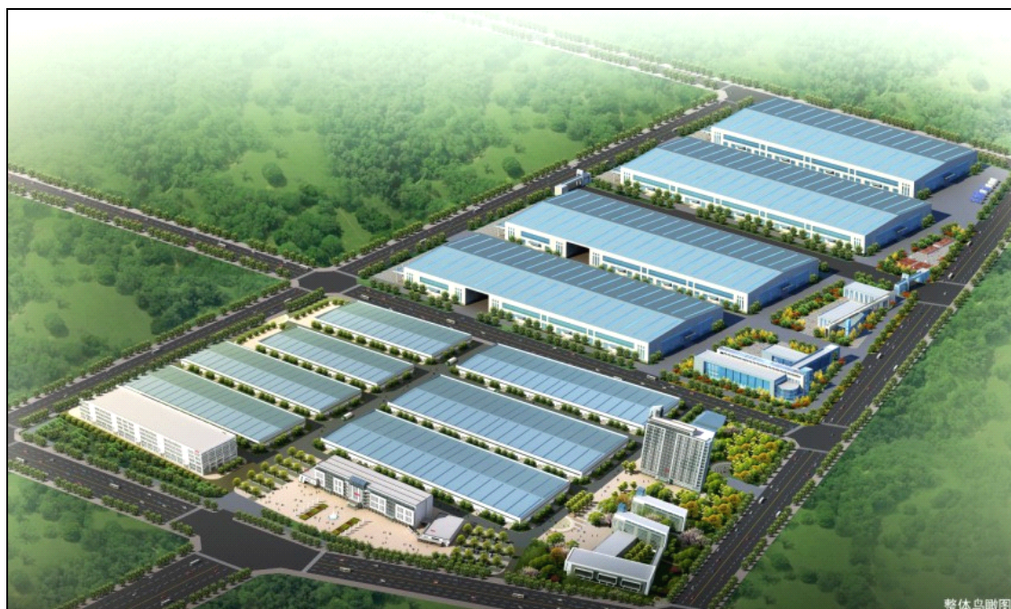
图为：公司南岗机电产业园
