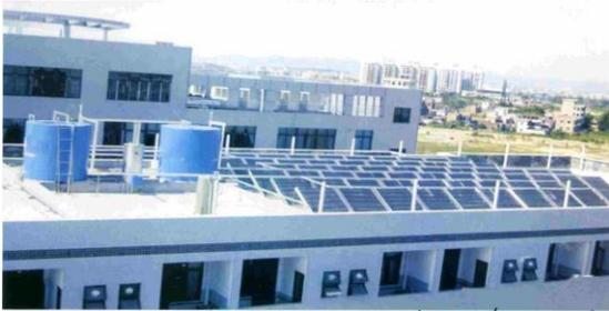
工业用太阳能热利用中温系统工程
