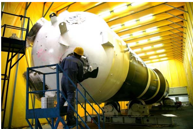
为福建宁德制造的核电蒸发器正在油漆待发
