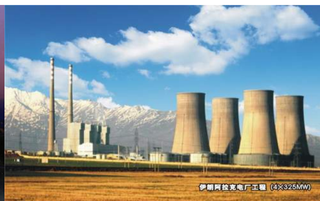
东方电气机组稳定运行于伊朗阿拉克电厂
