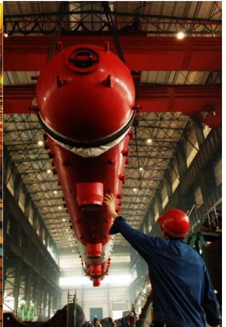
电站锅炉正在吊装
