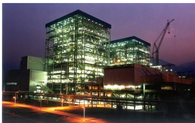
中国首台沁北电厂 600MW 超临界锅炉
