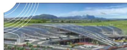
毛里求斯SSR国际机场扩建项目
