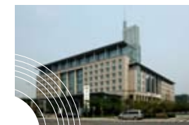
沈阳海关业务设施楼
