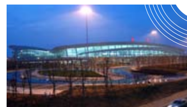
武汉天河机场航站楼工程
