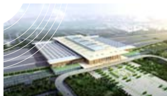
京沪高速铁路南京枢纽南京南站工程
