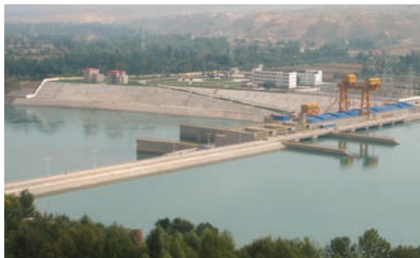
○ 公司海拔最高的水电站——青海直岗拉卡水电站
