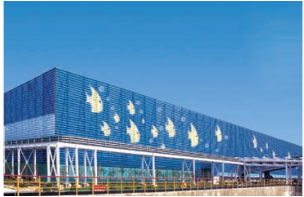
○ 浙江乌沙山发电公司建设挡风抑尘墙
