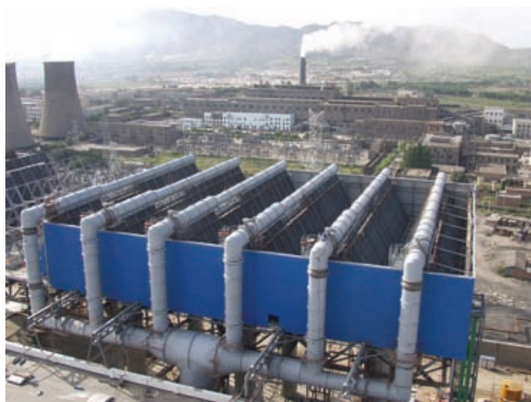
○ 火电机组广泛采用空冷节水技术
