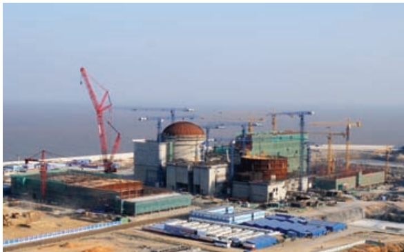
○ 建设中的福建宁德核电
