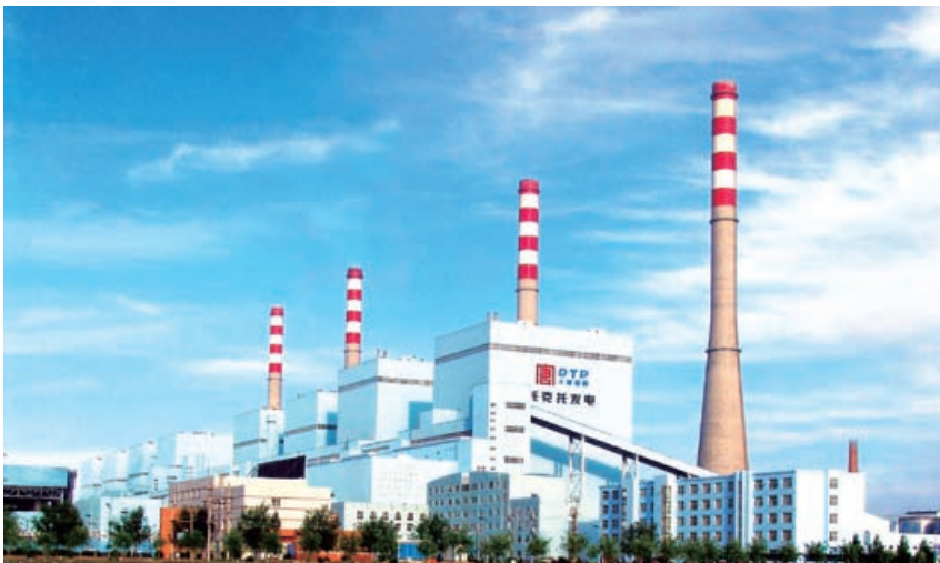
○ 内蒙古托克托发电公司分四期工程建设，装机容量4800兆瓦
