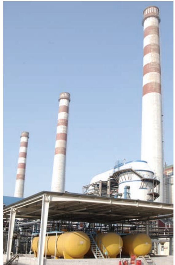
○ 高井热电厂在全国第一个实施在役机组脱硝改造，是国内环保设施最齐全的火电企业之一
