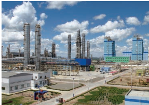
○ 内蒙古多伦煤化工项目
