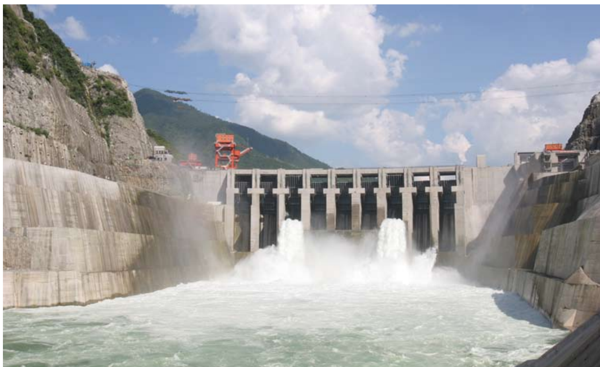
○ 重庆彭水水电公司完成293米终期蓄水目标
