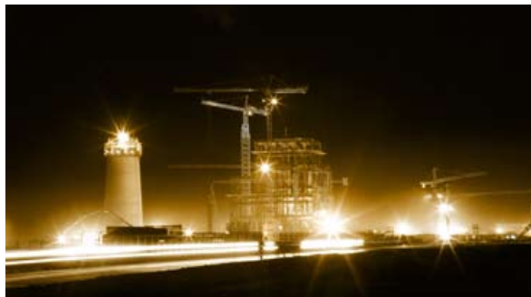
○ 内蒙古克什克腾煤制天然气项目
