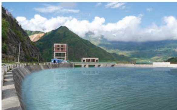
○ 云南马鹿塘水电站成功下闸蓄水
