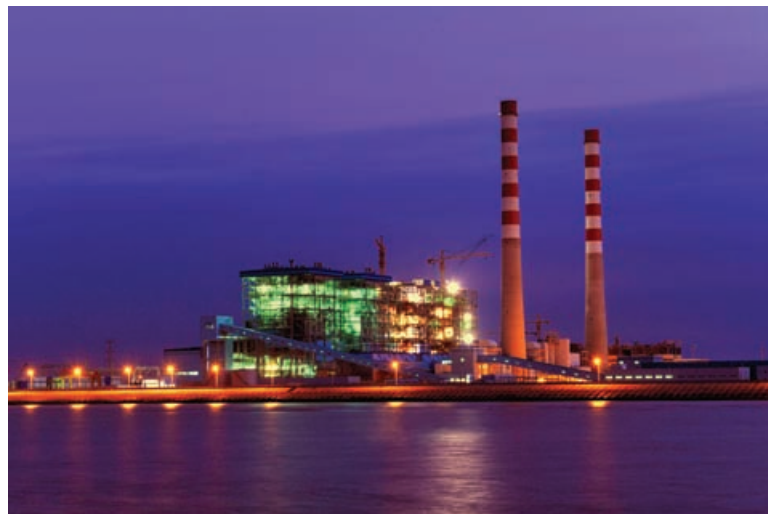
○ 采用“围海造地”建设的江苏吕四港发电公司，创沿海电厂建设史上规模最大、造地面积最多、深入海域最远的全国纪录
