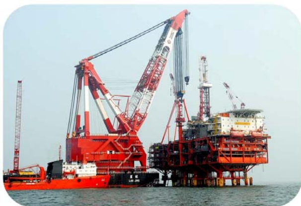
“蓝鲸”船进行旅大项目组块海上安装作业
