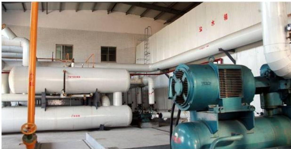
用于储存低谷电能的 800m<sup>3</sup> 的盐水冷却池以及制冷机
