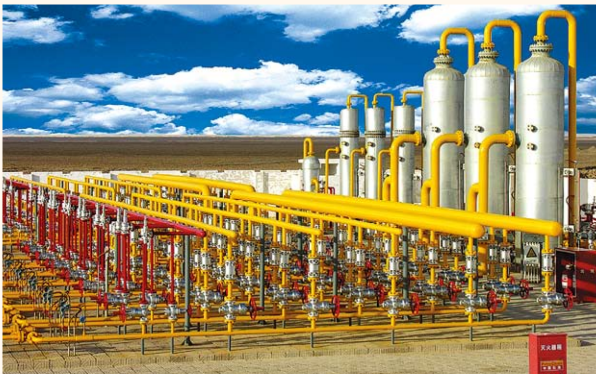
青海油田涩北气田作业现场
