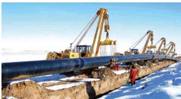
中亚天然气管道建设施工现场
