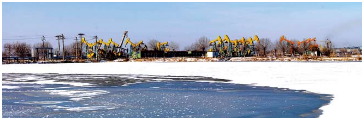
大庆油田生产作业现场
