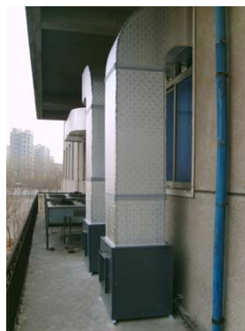
机房专用空调上安装热交换节能器—室外
