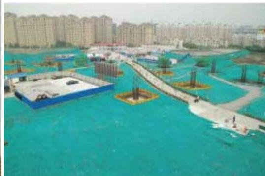
公司在施工现场采用绿色防护网完全覆盖裸露地表,有效的降低了由于泥土开挖风化而产生的扬尘对城市环境的污染。
