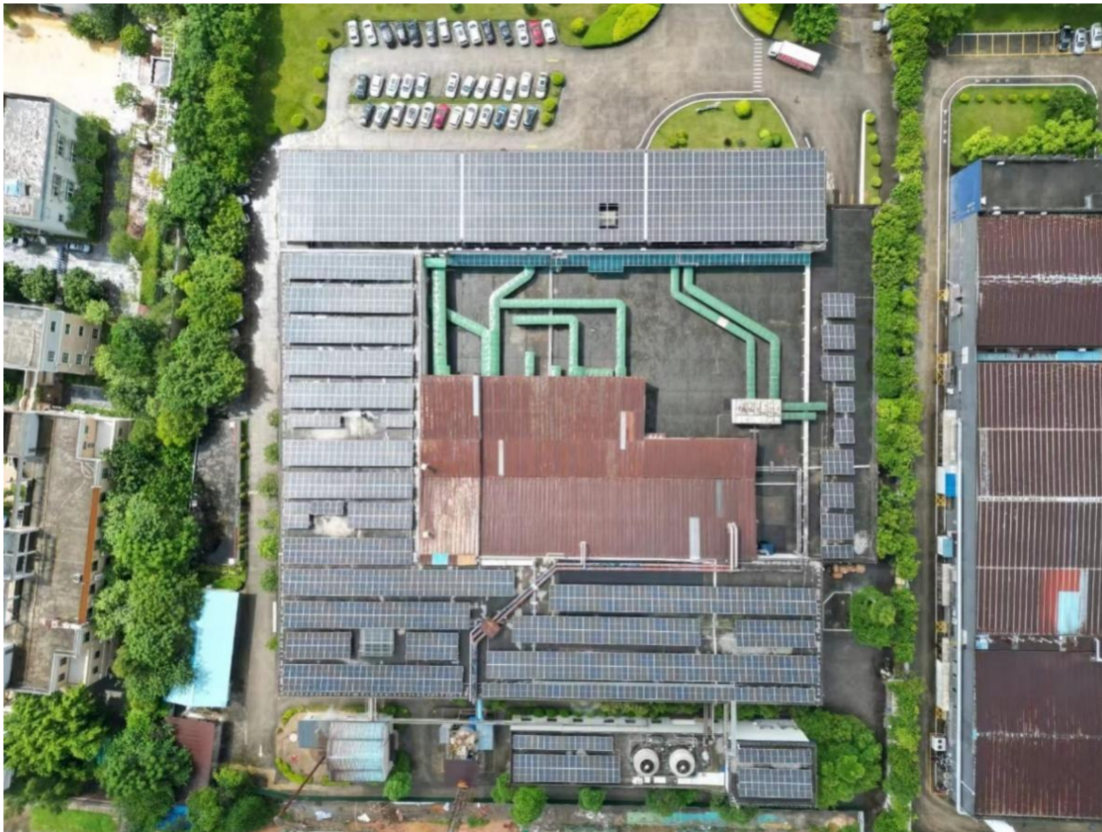
纬达光电现有厂房屋顶安装分布式光伏太阳能板，降低电力成本支出，提高节能减排效能
