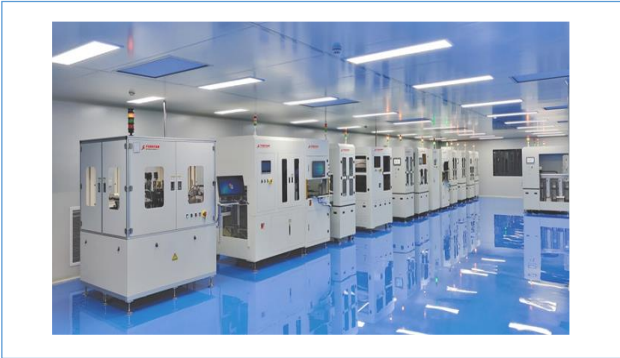
公司 HTCC（高温共烧）陶瓷基板、陶瓷管壳项目建设完工。
