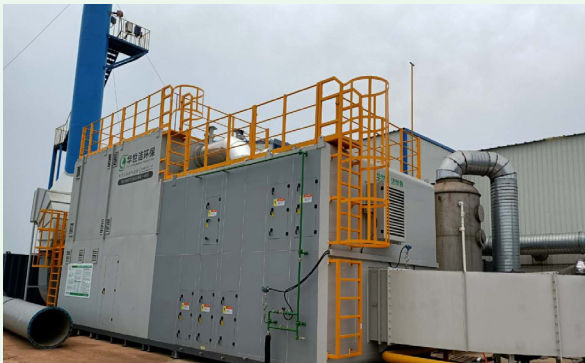
改造后（漆雾处理+沸石转轮+催化燃烧一体机）
