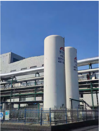
废气臭氧脱硝改造
