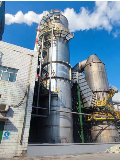
脱硫塔技术改造
